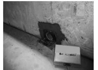
図 13 排水用ドレイン設置
