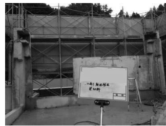
図 21 壁部と梁部の分離
