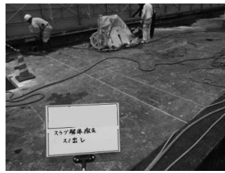
図 18 切断ライン(墨出し)
