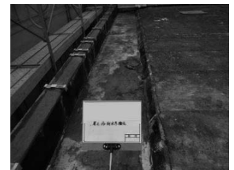
図 15 アスファルトルーフィング撤去
