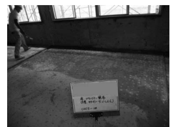
図 11 プライマー塗布
