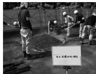
図 14 屋上防水保護砂利撤去
