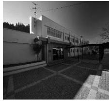
図1 対象建物の様子
