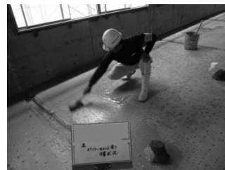
図 12 ポリマーセメント施工
